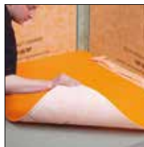
bij 8. Verlijm Schlüter®-DITRA resp. DITRA-HEAT erop vast
