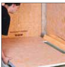
bij 3. Hellingsplaat onder de rand van de goot schuiven
