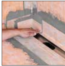
bij 3. Verlijm de KERDI-KERECK-binnenhoek
