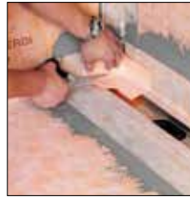
bij 2. Verlijm de KERDI-manchet / Snijd de KERDI-KERECK-binnenhoek op maat
