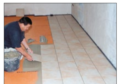
12 Verlegung des Fliesebelags auf Schlüter®-DITRA 25 in Dünnbettmörtel.
