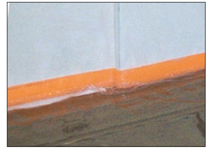
3 Einbau des Randstreifens BRS 810 mit Folienfuß. Bei Fließestrich sind die Randstreifen BRS 808 KF oder BRS 808 KSF mit Klebefuß zu verwenden.
