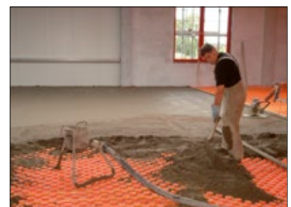
6 Druckprobe – Vor dem Einbringen des Estrichs ist eine Druckprüfung durchzuführen (siehe Druckprobenprotokoll, technisches Handbuch). Der Einbau des Estrichmörtels erfolgt ohne Bewehrung und ohne Bewegungsfugen, Estrichgüte CT-C25-F4. Ausnahme: im Türbereich, mit Kellenschnitt oder Dehnfugenprofil Schlüter®-DILEX-DFP sowie bei Bauwerkstrennfugen.
