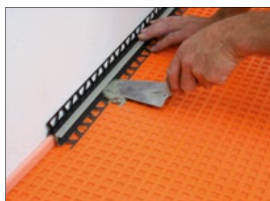
11 Einbau des Randbewegungsfugenprofils Schlüter®-DILEX-EK bzw. DILEX-RF.
