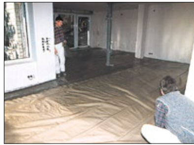
2 Einbau einer Abdecklage bei Verwendung von Fließestrichen.
