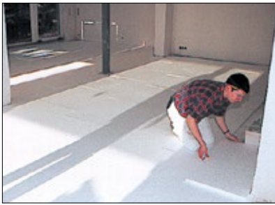
1 Verlegung der Wärme- und Trittschalldämmung auf ausreichend tragfähigem und ebenflächigem Untergrund.
